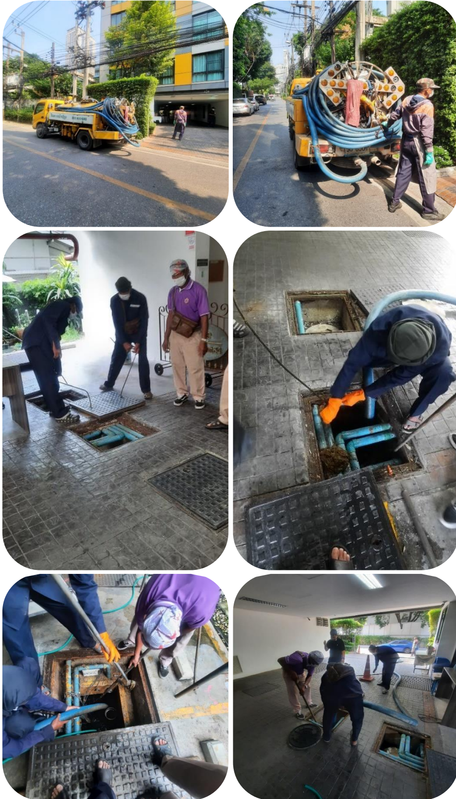
ภาพที่ 2-1.5(1) สูบตะกอนบริเวณส่วนตะกอนบำบัดน้ำเสีย
