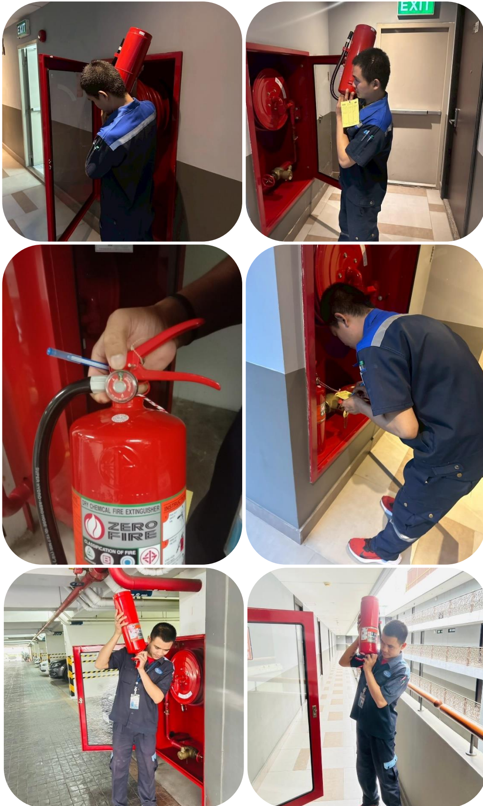
ภาพที่ 2-4.4(1) ตรวจเช็คตู้ดับเพลิง สายดับเพลิง และถังดับเพลิงประจำเดือน
